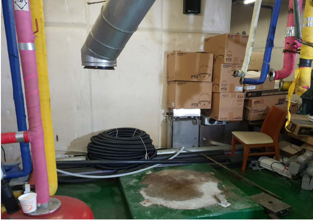
공종명: 기존보일러 철거
