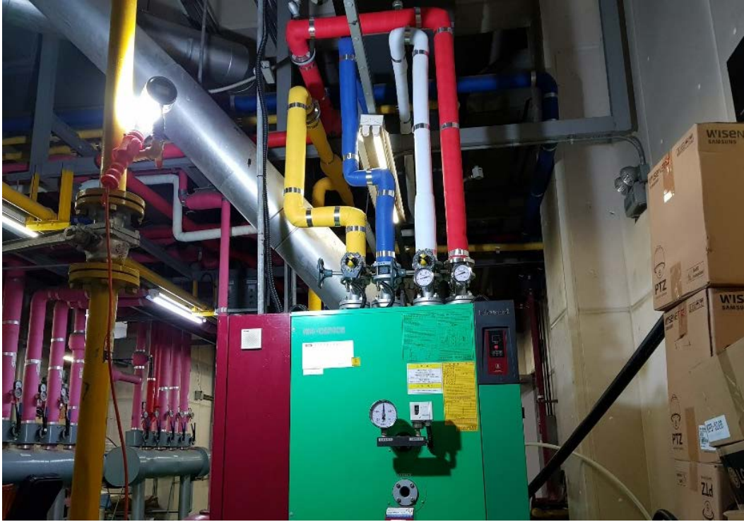
공종명: 신규보일러 배관 연결 완료
