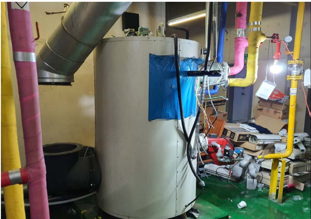
공종명: 기존보일러 철거
