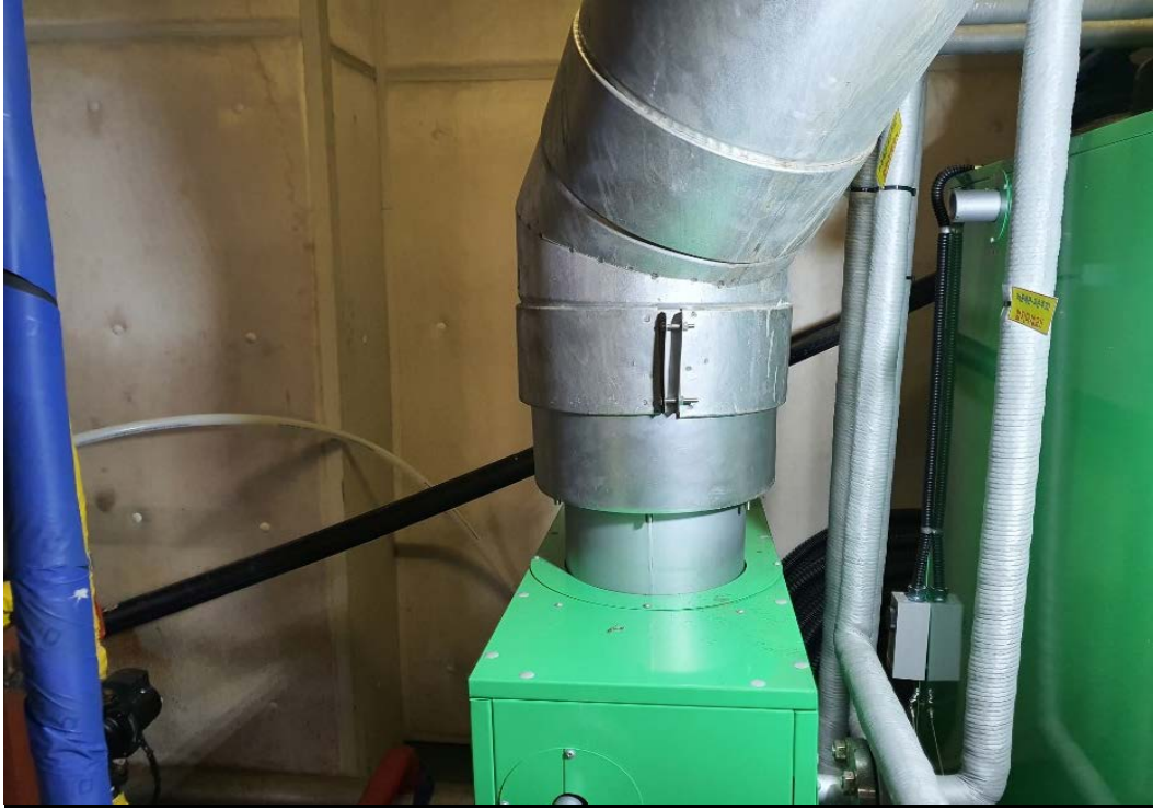
공종명: 신규보일러 연도 연결 완료
