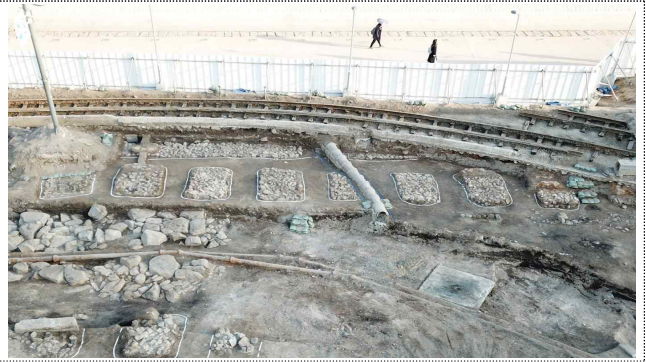
동서 행랑 기초 전경
