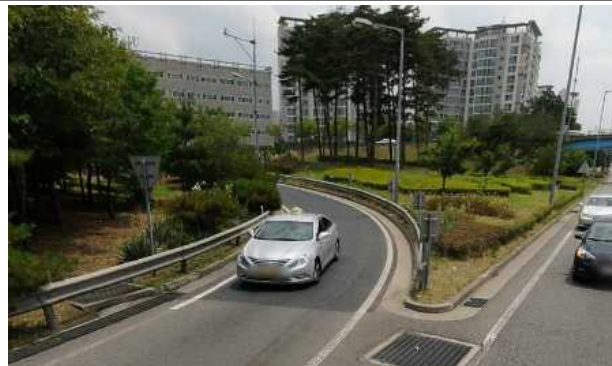
영동대교 진출입램프 진출부(일산 방향)
