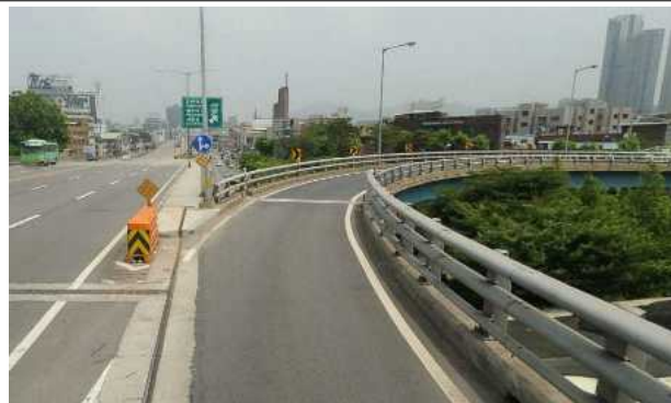
영동대교 진출입램프 진입부(일산 방향)
