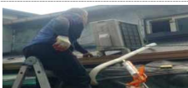
공용에어컨 설치(영등포 쪽방촌)
