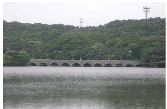
교량 하부 측면전경
