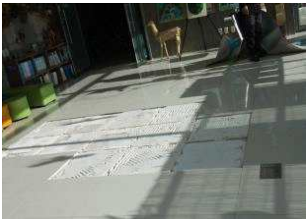
[유지관리] 센터 바닥 타일 보수작업 (겨울철 타일 들고 일어남)
