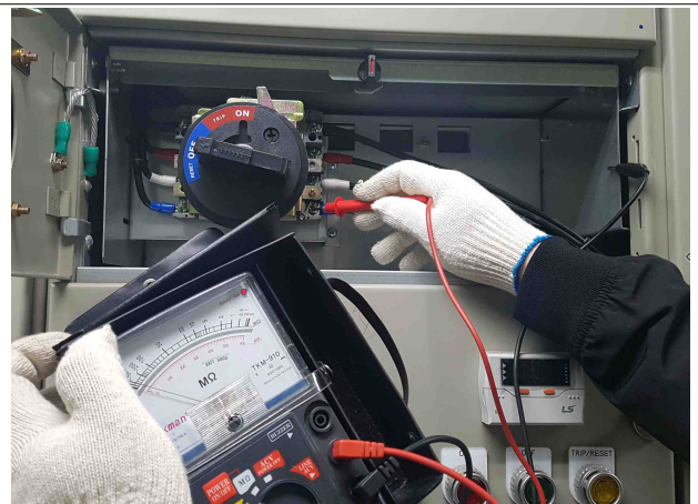
< MCC판넬 절연저항 측정 사진 >
