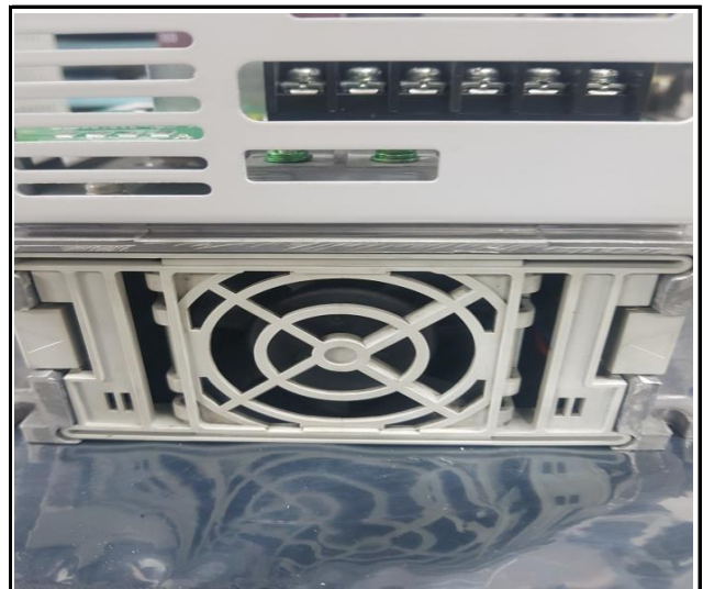
내용 냉각 FAN 교체 후
