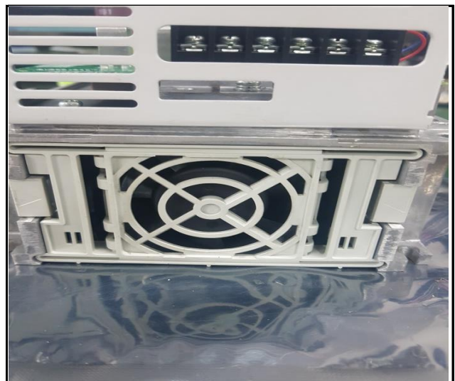
내용 냉각 FAN 교체 후
