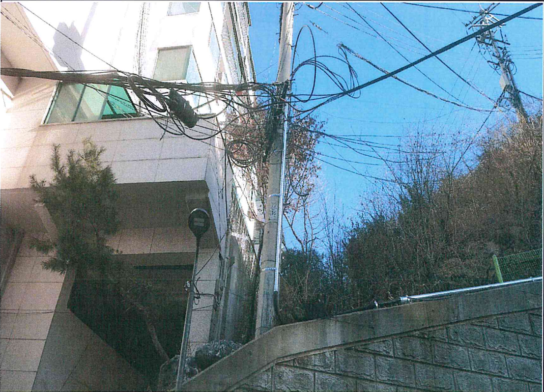
전주입상파이프 설치 후
