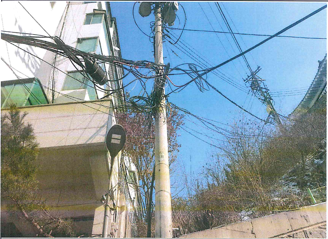
전주입상파이프 설치 전
