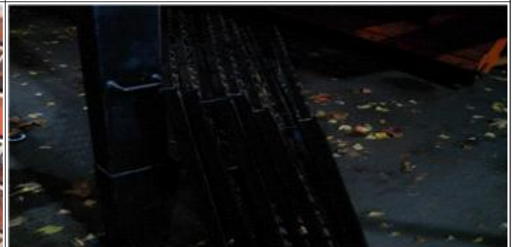
15톤살포기(8호) / 스크린망 수리 후
