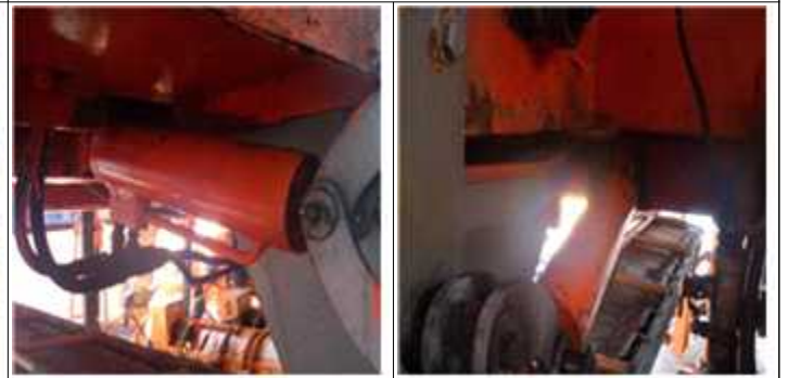
15톤살포기(8호) / 슈트실린더 교환 후
