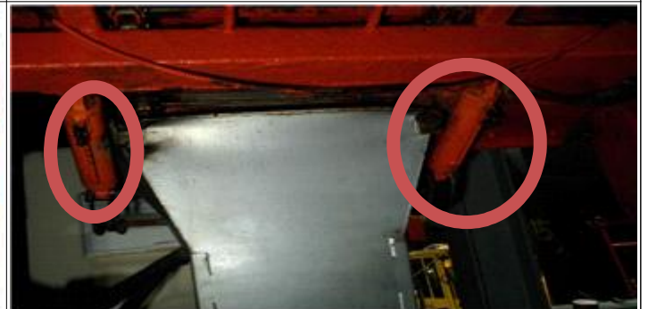
15톤살포기(3호) / 슈트실린더 교환 후
