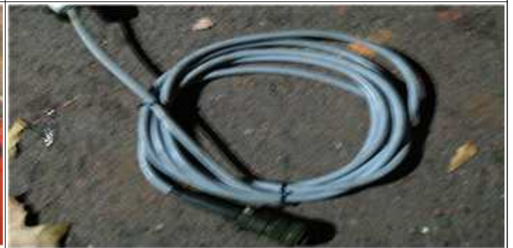
15톤살포기(3호) / 컨트롤케이블 교환 후
