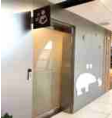
자동문 설치 (김포공항 유아휴게실)
