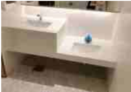
높낮이가 다른 세면대 설치 사례 (자료: 서울시서울시유니버설디자인센터, 2022b: 30)
