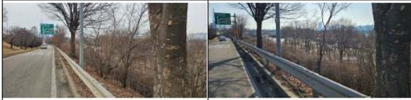
작업 전<2024년 상반기 올림픽대로(청담2교~잠실철교)> 작업 후
