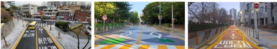
노면표시 정비(용산 일민유지원) 도로 디자인 포장(노원 청원초) 적색 미끄럼방지포장(강동 신암초)
