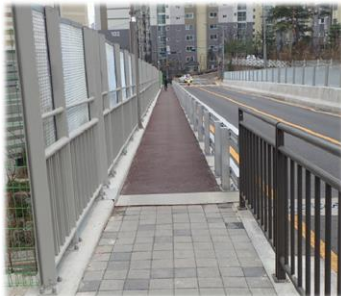
기타부재(교면포장(아스팔트), 보도부, 방호울타리(콘크리트), 차량방호책, 난간/연석, 배수시설(배수구, 배수관))
