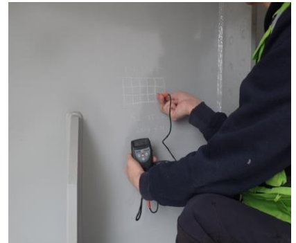
강재 도막 두께 측정
