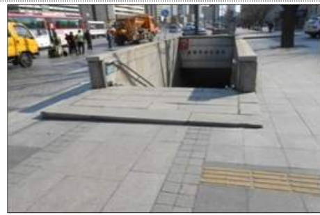
▲ 지하보도앞 점자블록 미설치
