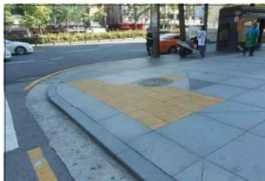
▲ 턱낮춤 단차과다 및 점자블록 설치방법 부적정
