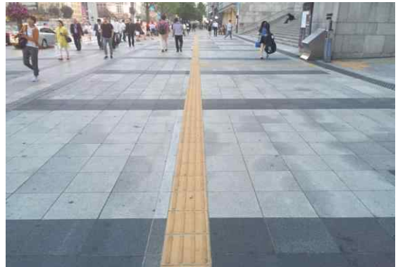
▲ 점자블록 재설치 (정비 후)
