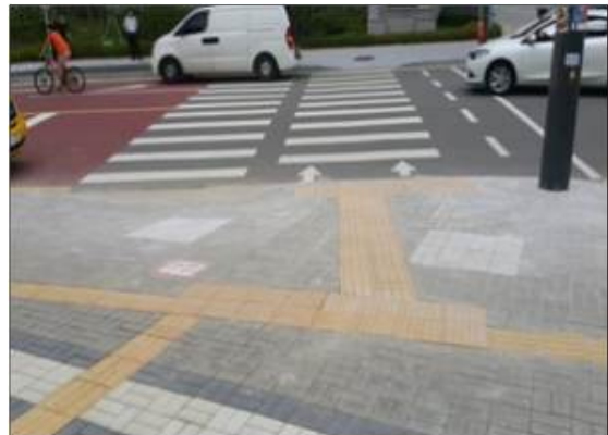
▲ 선형블록 유도방향 부적정 (정비 후)
