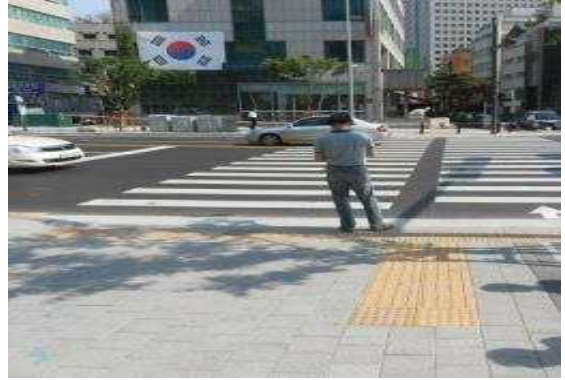
▲ 전폭 턱낮춤 및 점자블록 재설치 (정비 후)
