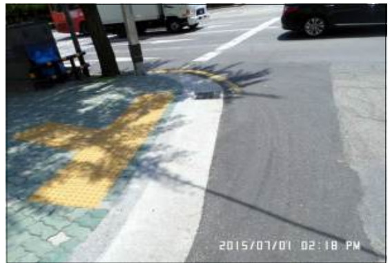
▲ 점자블록 재설치 (정비 후)
