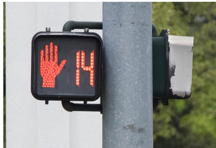
[ 현장 설치 사진 ]
