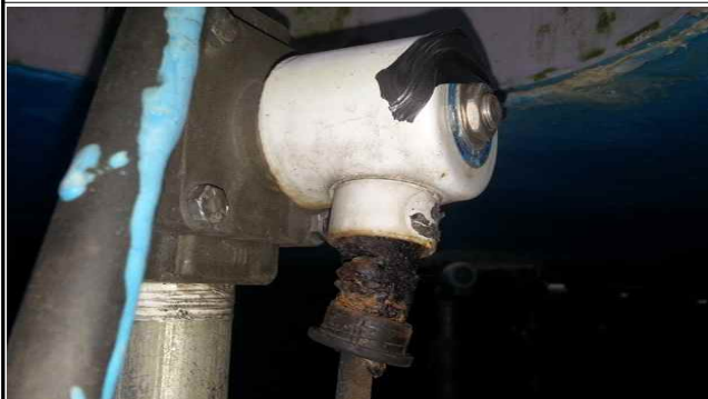
바닥분수 밸브, 노즐 등 보수
