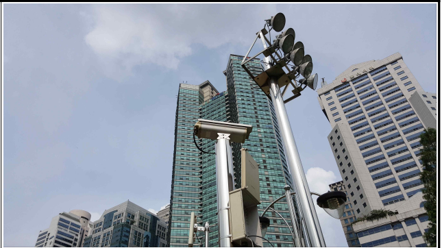
CCTV 교체 설치(화소 변경)
