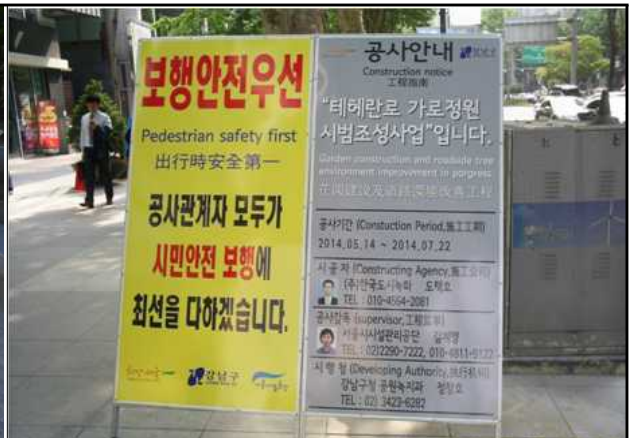
적정 : 공사안내간판 규격 및 내용 적정
