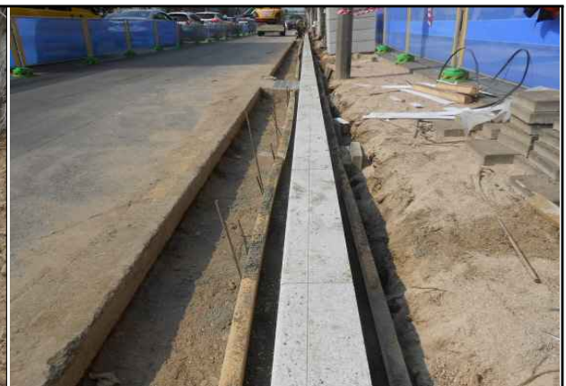
적정 : 경계석 거푸집 시공 양호
