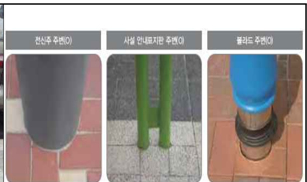
〈그림 3.79〉 기둥 접속부 올바른 시공사례
