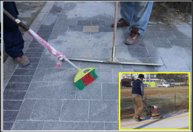
적정 : 모래채움 및 상부 다짐(고무패드장착)
