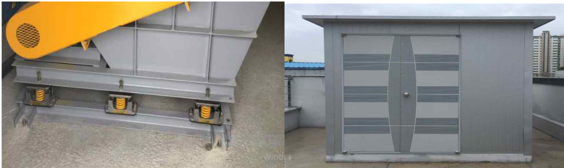
Figure 11. 진동 충격 방지용 장치(좌) 및 소음 방지룸(우)
