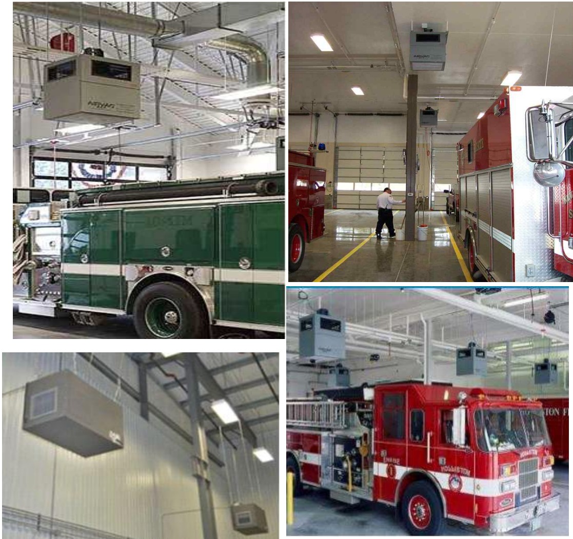
Figure 22. 소방청사 차고지내 입자물질 및 VOC 제거 필터
