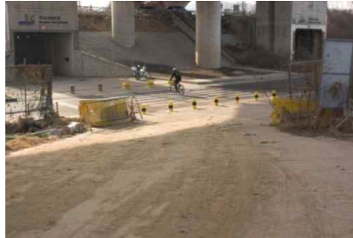
1) 주차장 진입로 좁은 회전반경 - 진입구 재배치
