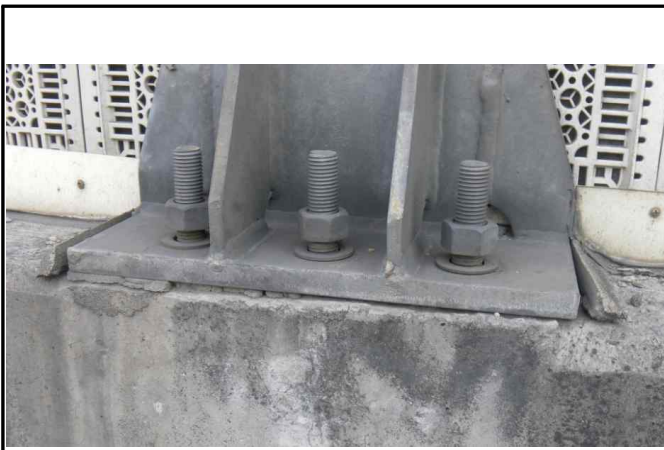
PLATE 접합부 콘크리트 파손
