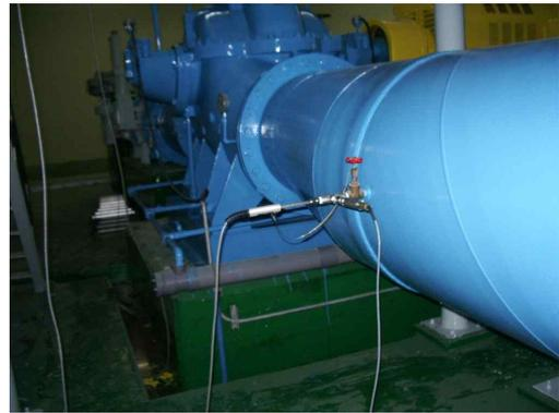
[사진12] 7호기 압력 및 온도 센서
