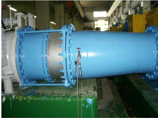
[사진11] 7호기 토출측 센서 설치
