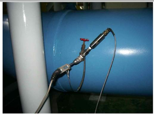
[사진2] 온도 및 압력센서설치 완료
