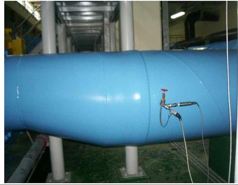
[사진10] 7호기 흡입측 센서 설치
