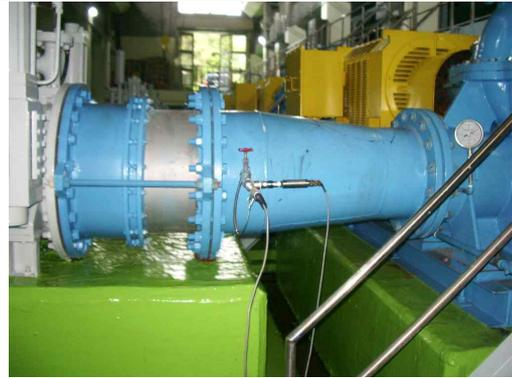
[사진14] 4호기 토출측 센서 설치
