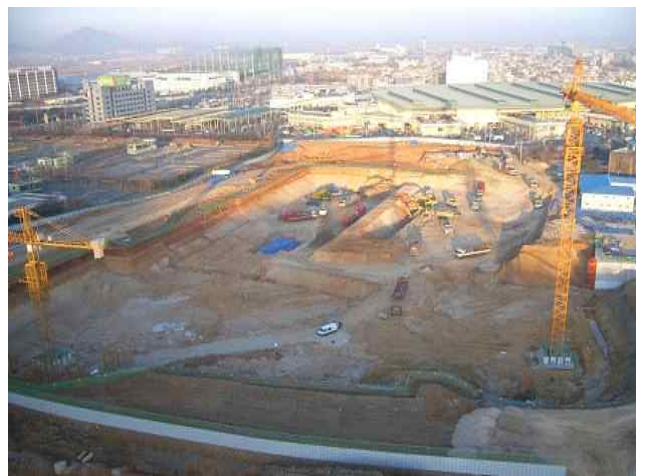
터파기 완료후 전경사진(2006.02)
