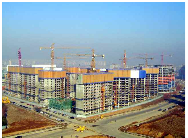
아파트 골조 작업 전경사진(2006.12)
