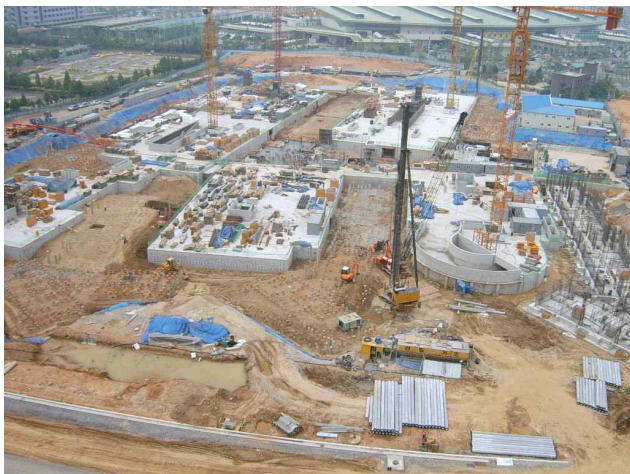
지하주차장 골조 완료 전경사진(2006.05)
