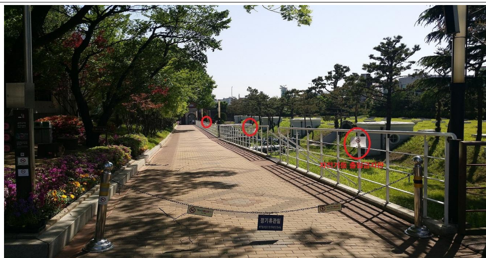
보호철물에 자전거, 애견등 출입제한 안내판 제작설치
