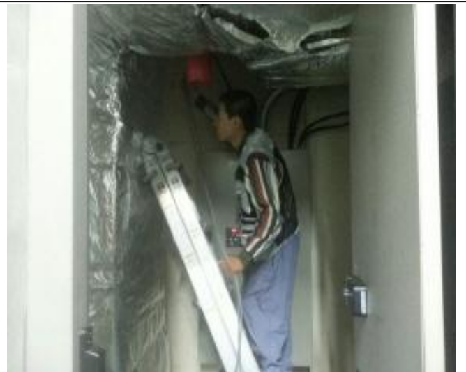
선로포설 작업 시행
