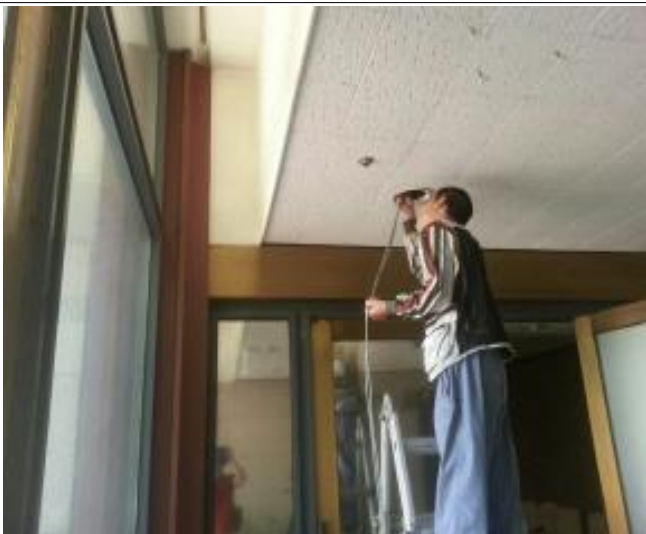
선로포설 작업 시행
