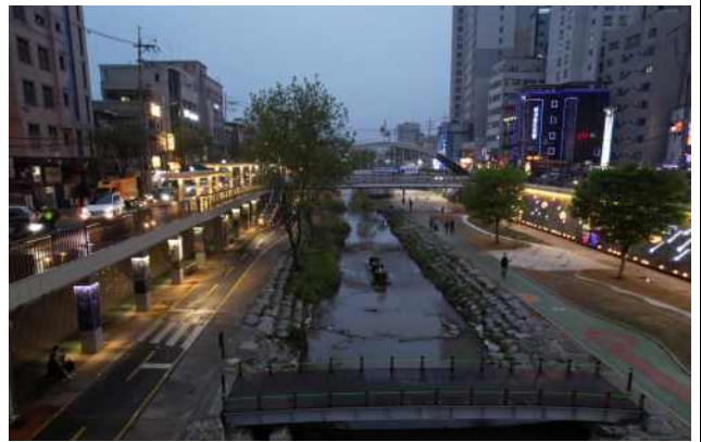
도림천 수변테라스 조성현황(야경)
