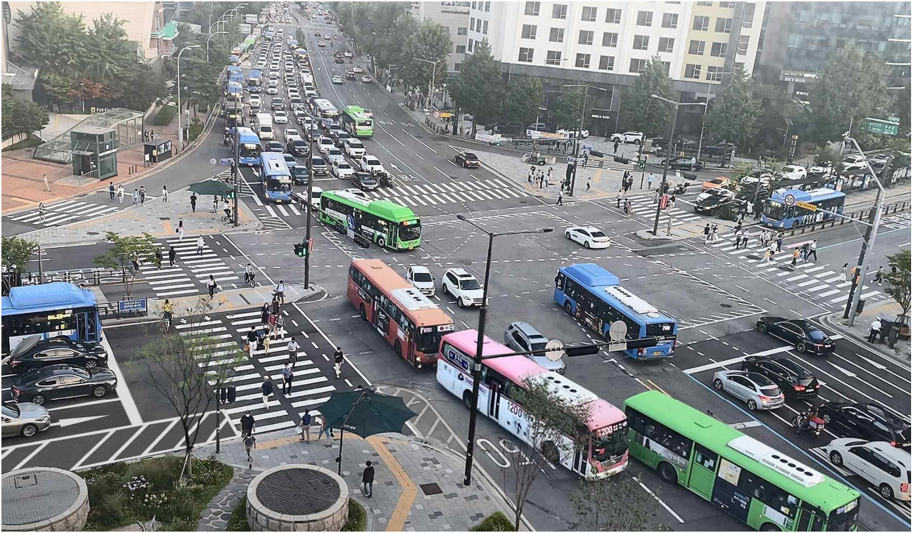
〈서대문역교차로 (공사 전)〉
