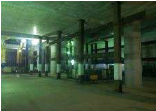
〈정거장 구조물 공사〉
