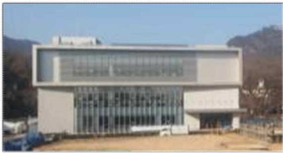
[차량기지 건축공사 완료]
