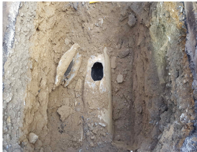
폐공캡 사용 가능한 하수관 파손 상태(예시)
