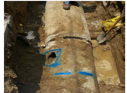
폐공캡 사용 가능한 하수관 파손 상태(예시)
