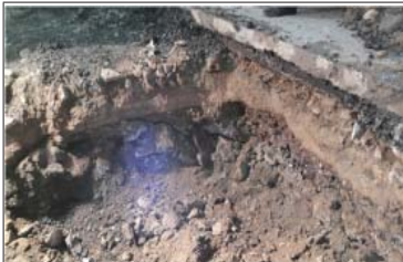
건축 폐기물 매립(돌, 페콘크리트)
