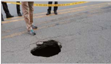
'16.5, 도로함몰 발생 [긴급보수포장 관리기법으로 보수] 1차 긴급보수 : 2차 사고 우려시 시행 2차 항구보수 : 굴착원인조사→원인보수→포장
