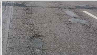
'18.2, 포트홀 발생 (주변포장에 균열 발생) [노후포장 관리기법으로 보수] 포장조사(이력/상태/지지력)후 D.T로 공법설계하여 포장
