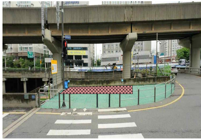
현장사무실 점용 위치 (대림2교부근) (관할구역 : 구로구), A=18m 2
