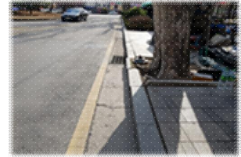
〈 가로수 이격불량 및 뿌리 용기로 인한 경계석 이탈 사례 〉
