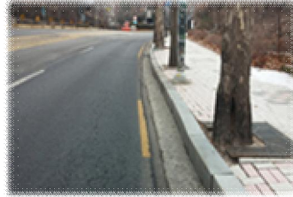
〈 가로수 이격불량 및 뿌리 용기로 인한 경계석 이탈 사례 〉
