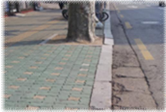
〈 가로수 이격불량 및 뿌리 용기로 인한 경계석 이탈 사례 〉
