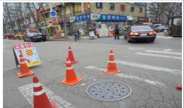
맨홀 상부 전경
