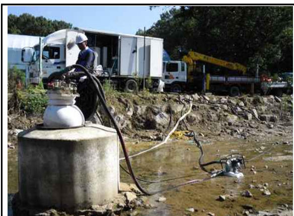
공기를 이용한 라이닝 경화 및 양생
