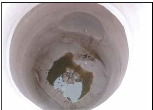
라이닝 경화 후 내부 전경
