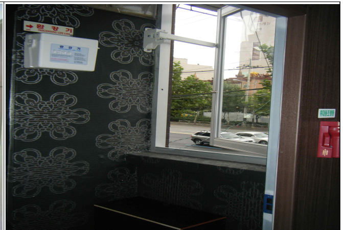
부속실내 완강기 및 비상구 설치
