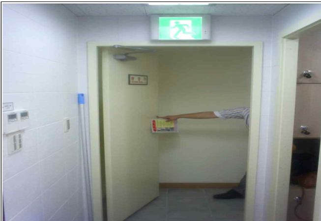
통로의 끝부분에 부속실 설치
