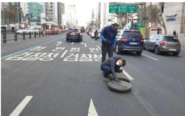
주변 관로 음청식 탐지 및 200mm 관로 다점식 음수집센서 2개소 예약탐사 설치 중
