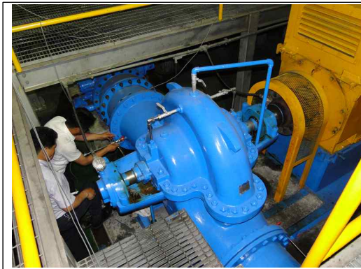
[사진1] 상도 3호 계측 센서 설치 중
