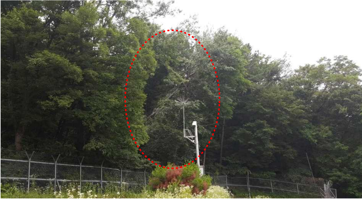
내곡가압장 경계 울타리 밖 수목 넘어진 모습(경계 울타리 훼손 우려됨) [원경사진]
