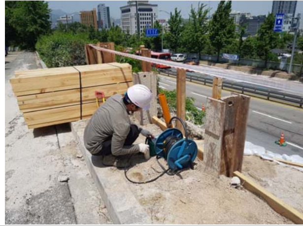
지중 경사계 1번 측정 전경
