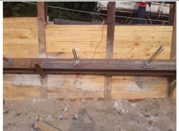
앵커 하중계 설치 전경
