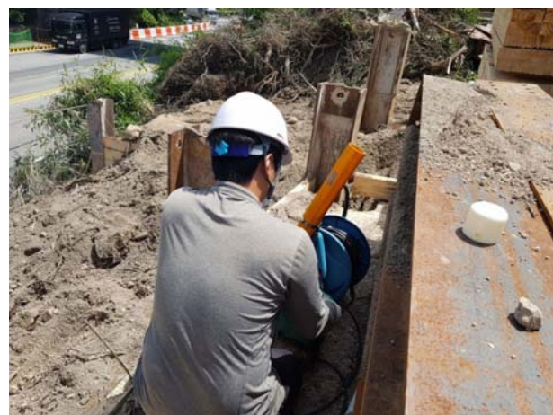
지중 경사계 3번 측정 전경
