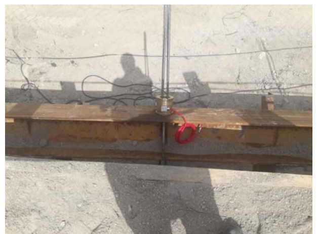
앵커 하중계 설치 전경
