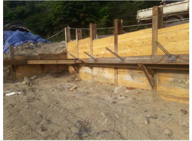
앵커 하중계 설치 전경
