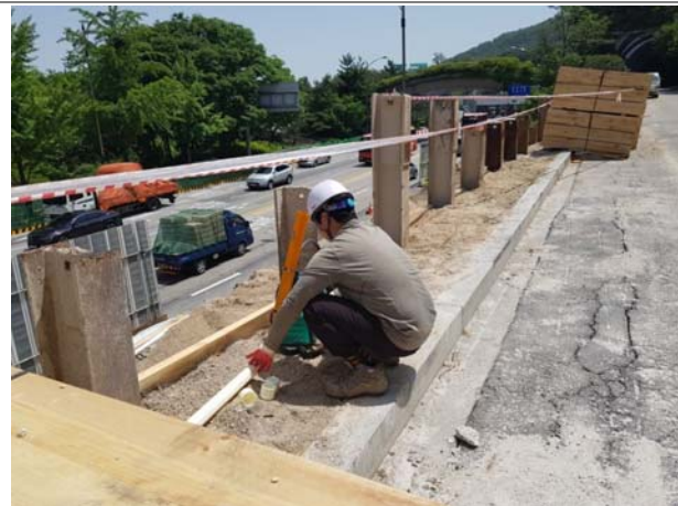
지중 경사계 2번 측정 전경
