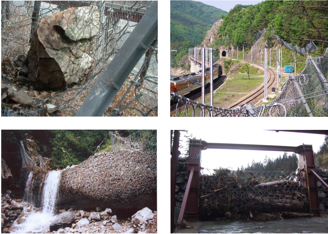
사진 4.1 링네트 공법의 시공사례
