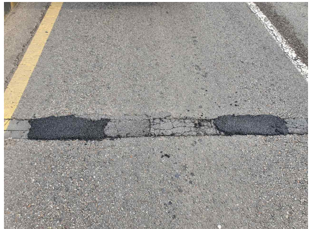
< 증산지하차도(상행) 외 소파 보수 후 사진 >
