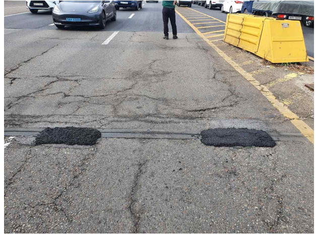
< 증산지하차도(상행 초입 1차로) 소파 보수 전·후 사진 >
