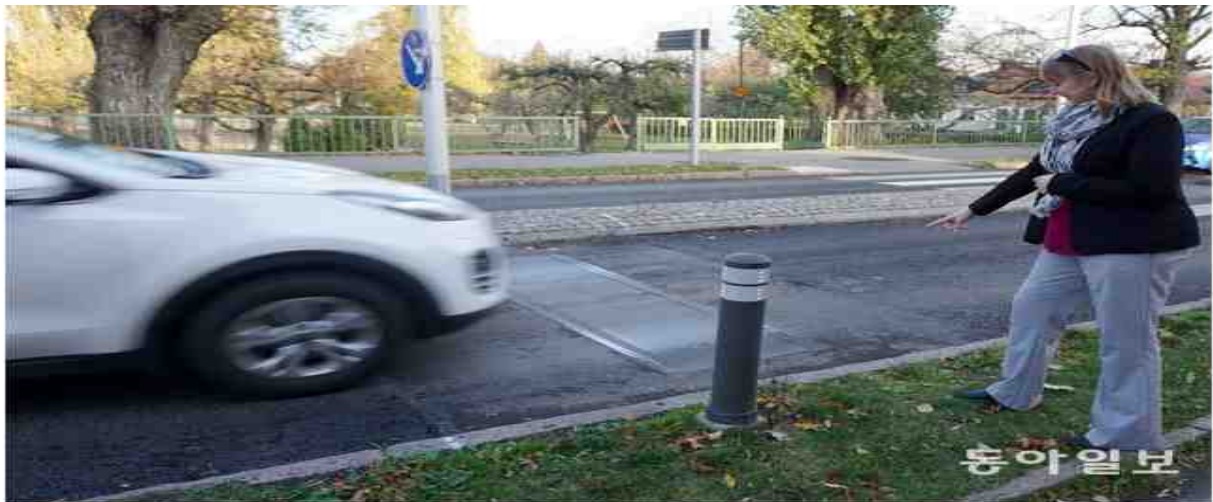
지난달 1일(현지 시간) 스웨덴 린셰핑시에서 에데바의 카린 비클룬드 마케팅매니저가 도로에 설치한 속도 감속 장치 '액티범프'를 소개하고 있다. 액티범프는 제한 최고 속도를 넘어 빠르게 달리는 차를 감지해 노면 깊이를 일부러 낮춰 운전자가 속도를 줄이도록 유도한다. 린셰핑=구특고 기자 kootg@donga.com
