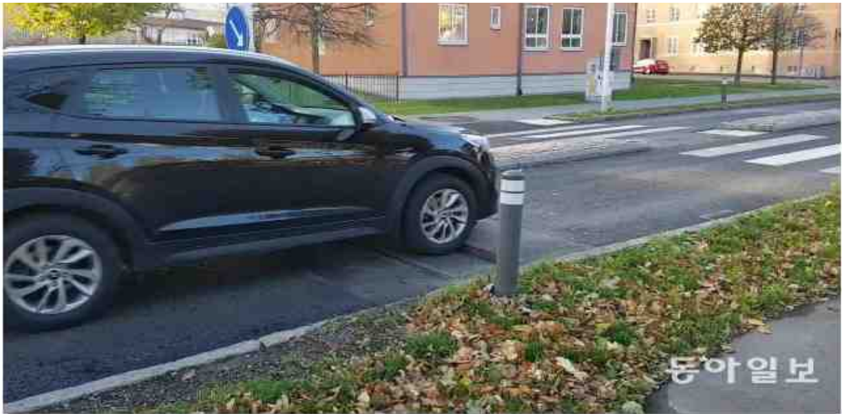
지난달 1일(현지 시간) 스웨덴 란세팡시의 한 도로에 설치된 액티브범프가 제한최고속도를 넘어 달리는 차량을 감지하고 노면 높이를 낮추고 있다. 이를 통해 운전자가 속도를 줄이는 효과를 낼 수 있다. 란세팡=구특고 기자 kootg@donga.com
