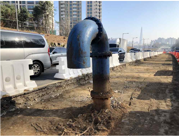
STA.1+480 환기구 맨홀 설치 전
