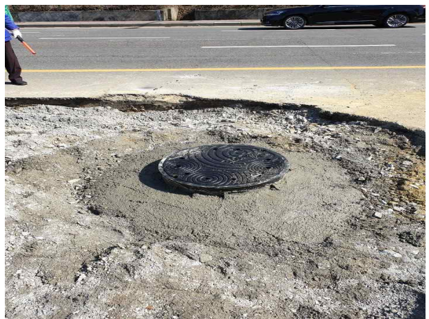
STA.1+700 환기구 맨홀 설치 후
