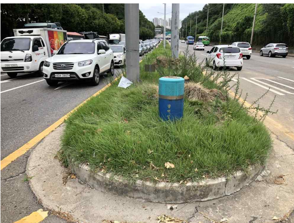
STA.1+700 환기구 맨홀 설치 전
