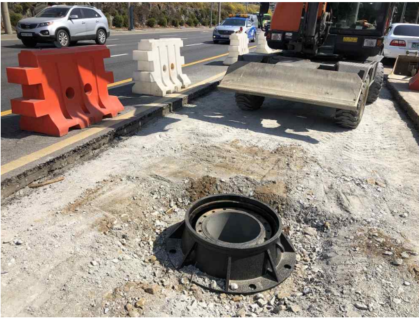
주변토공정리 및 환기구 맨홀설치
