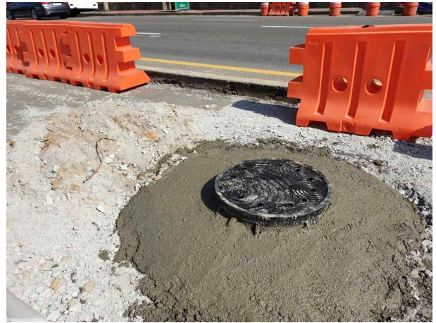
보강 콘크리트 타설
