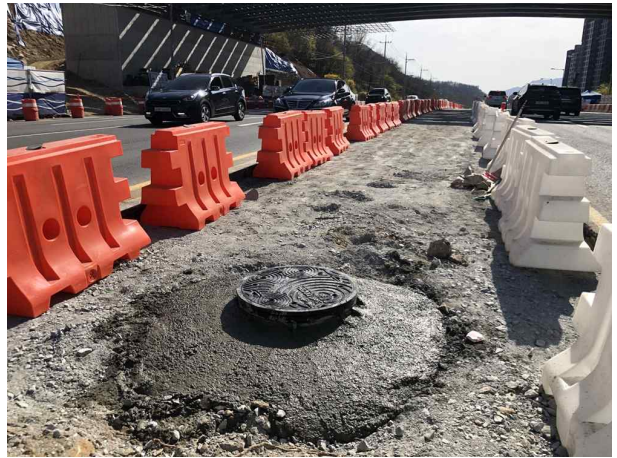
STA.1+480 환기구 맨홀 설치 후
