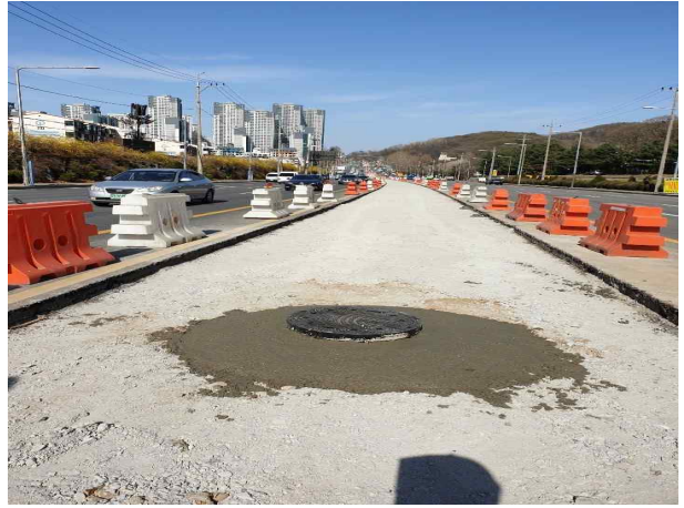
STA.0+502 환기구 맨홀 설치 후
