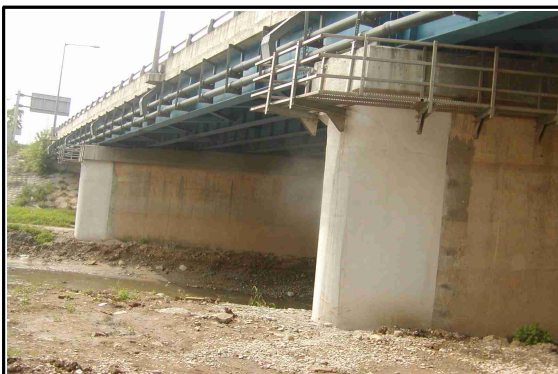
【사진 I .2.7】 교각부 면보수
