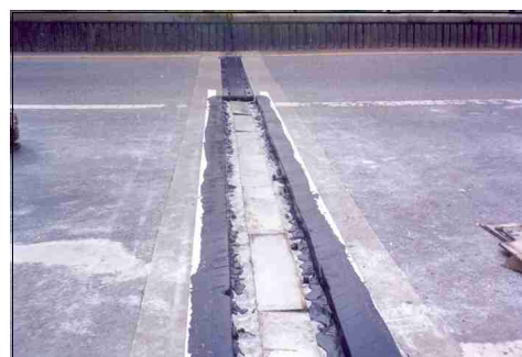
④ 도로봉합제 지지판 설치
