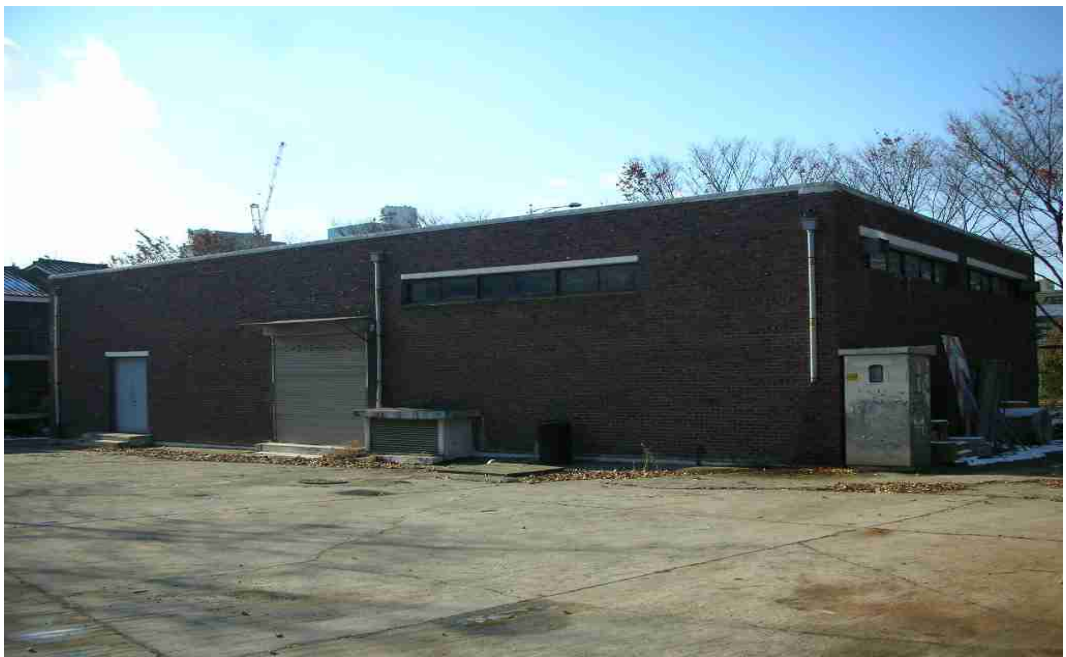
오금배수지 관리동 전경
