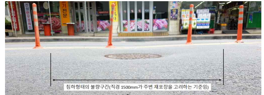
[그림 3.2] 침하형태 불량구간 예시
