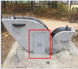
GTZSD-WD100 점검구 체결 상태
