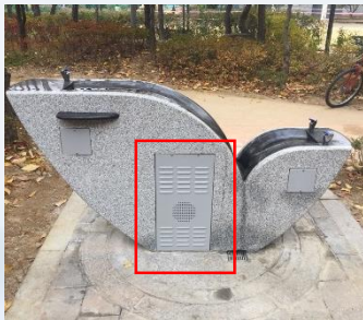
GTZSD-WD100 점검구 체결 상태
