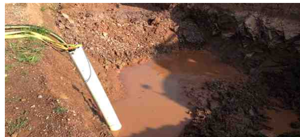
(배수용 sump 또는 pit에서의 토사량 측정)
