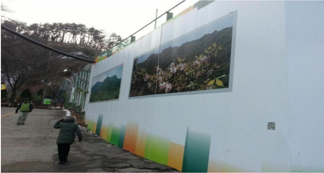
내 용 강남순환도시고속도로 5공구 가림벽 설치 현황
