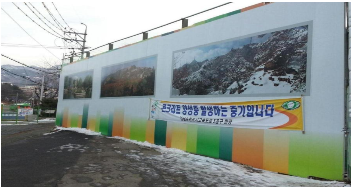
내 용 강남순환도시고속도로 5공구 가림벽 설치 현황
