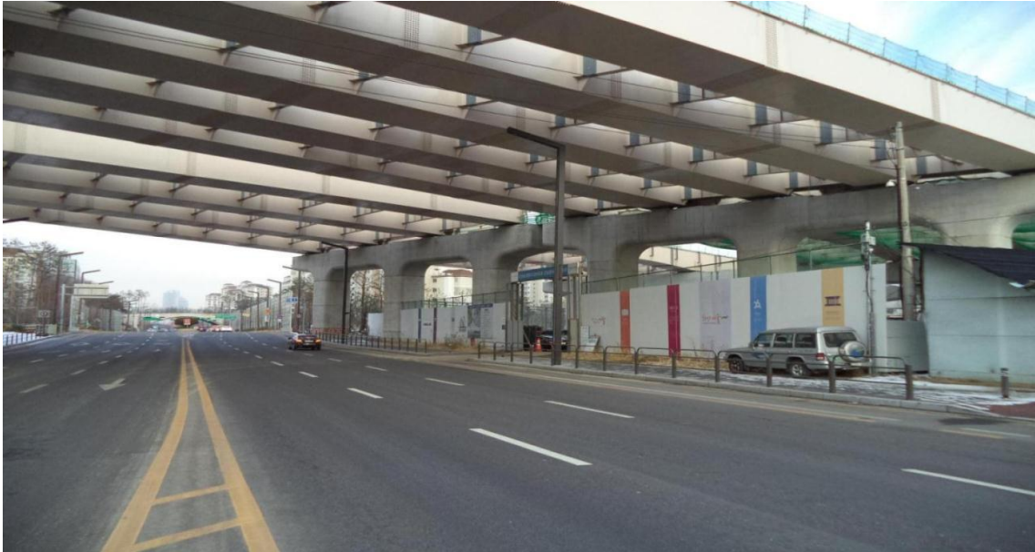
내 용 강남순환도시고속도로 7-2공구 가림벽 설치 현황
