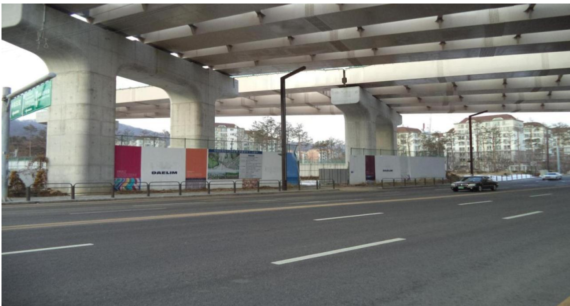
내 용 강남순환도시고속도로 7-2공구 가림벽 설치 현황
