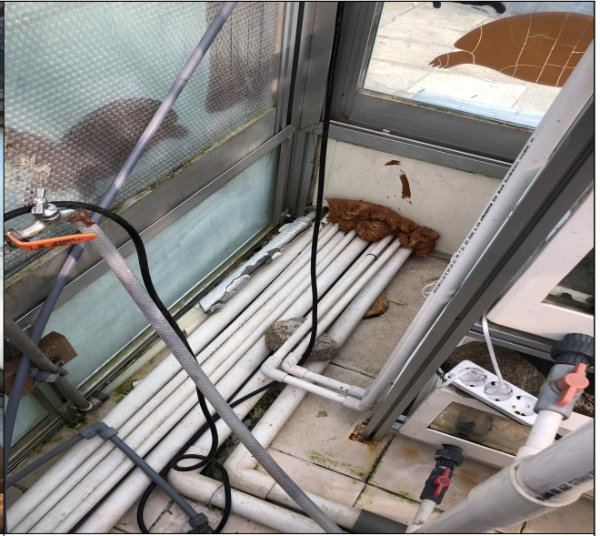
공사전 사진(남생이 급수 시설)
