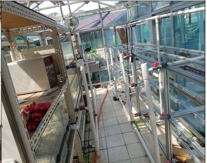
공사 중 사진
